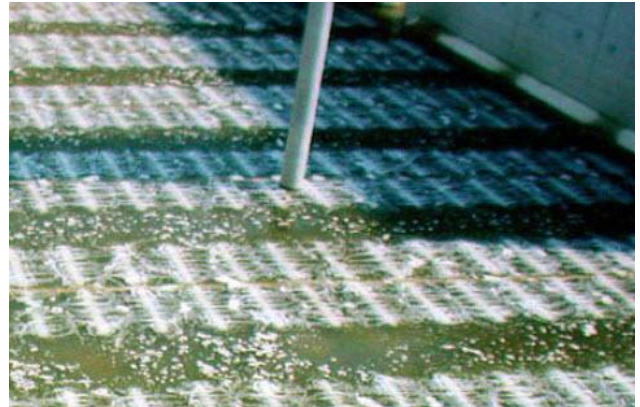
ด้วยการทดสอบการจ่ายอากาศหลายต่อหลายครั้ง ในบ่อบำบัดที่มีอยู่เดิมเป็นการพิสูจน์อย่างมั่นใจถึงสถานะความเป็นผู้นำของ Elastox ® -R Tube Air Diffuser ต่อระบบการเติมอากาศแบบฟองฝอยละเอียดอย่างไม่มีข้อกังขา
